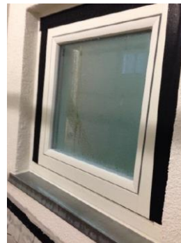
Bild 3. Außenseite der Fensterkonstruktion – dem Klima ausgesetzte Seite
