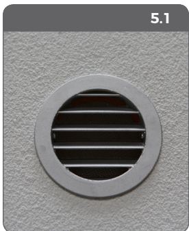
Montering af ventilationsrist.
